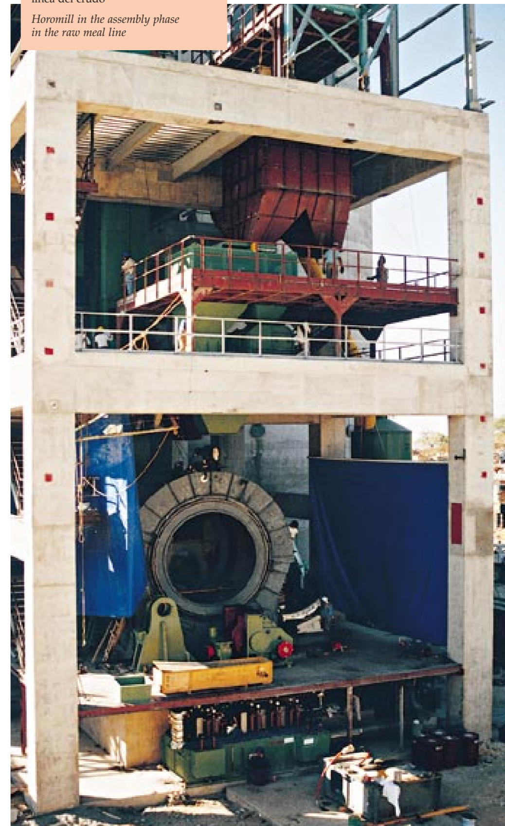
Horomill in fase di montaggio nella linea del crudo
